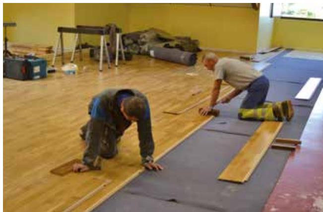
Pose du nouveau parquet.
