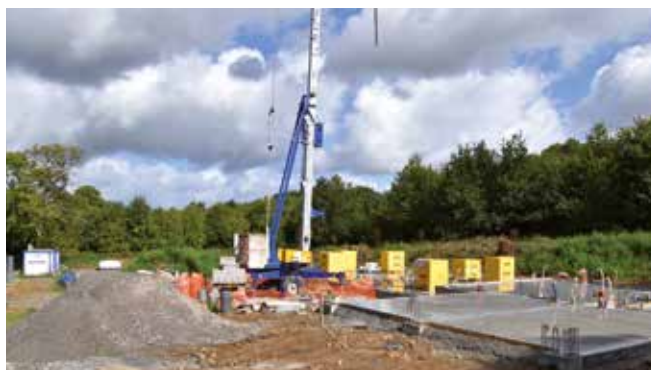
Les travaux en cours, allée des Châtaigniers.
