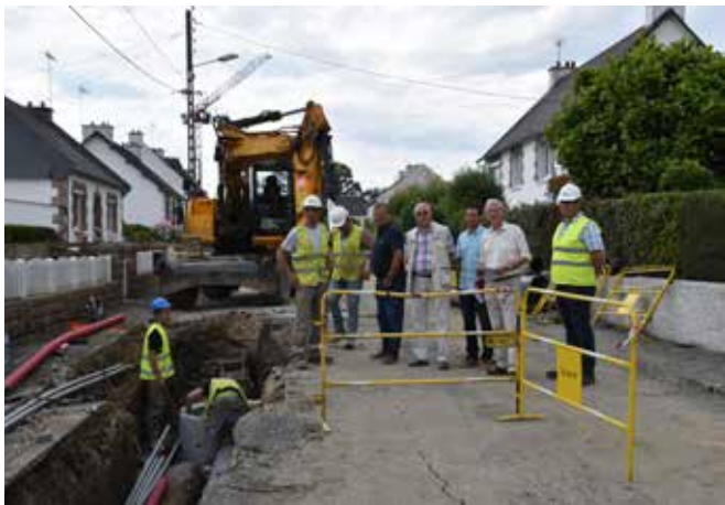
Visite du chantier de la rue Alexandre Lédan
