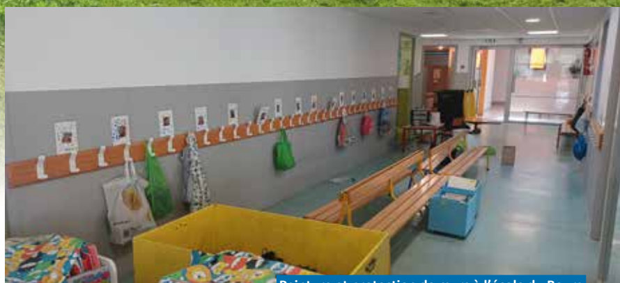
Peinture et protection de murs à l'école du Bourg
