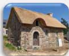
Réhabilitation de la Maison des Potiers 160 000€
