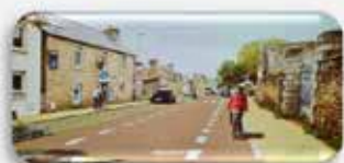
Voirie (Requalification de la rue de l'Armor, réfection des trottoirs avenue Pierre Loti, ...) 915 000 €
