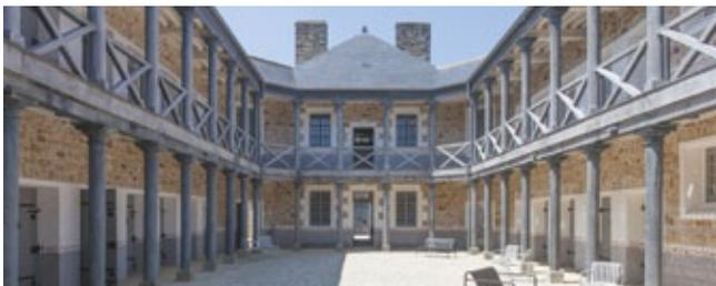
Les cellules sont disposées autour d'une cour centrale entourée d'une coursive soutenue par des colonnes. Cette disposition permet la circulation et la surveillance depuis la loge du gardien. Des cours périphériques et un double mur d'enceinte complètent cet ensemble architectural original.
