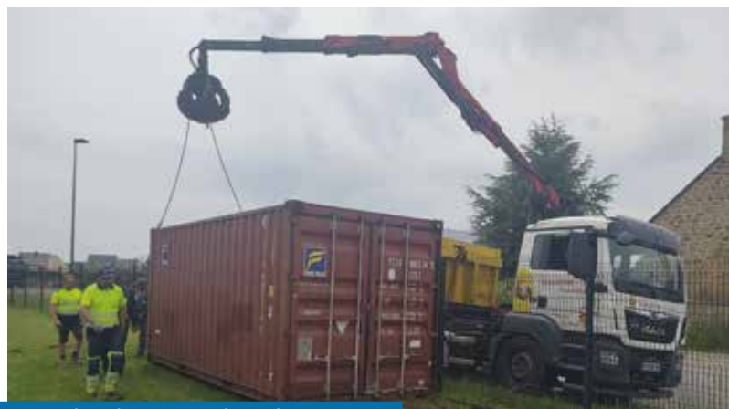
Mise en place du container de stockage au Rucaër
